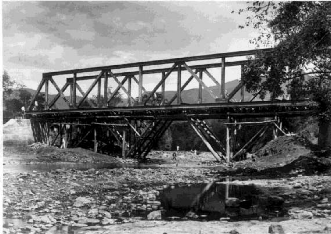
Obra # 314 , Km 109+148 , fertig eingefahren. 40m Lichtweite
