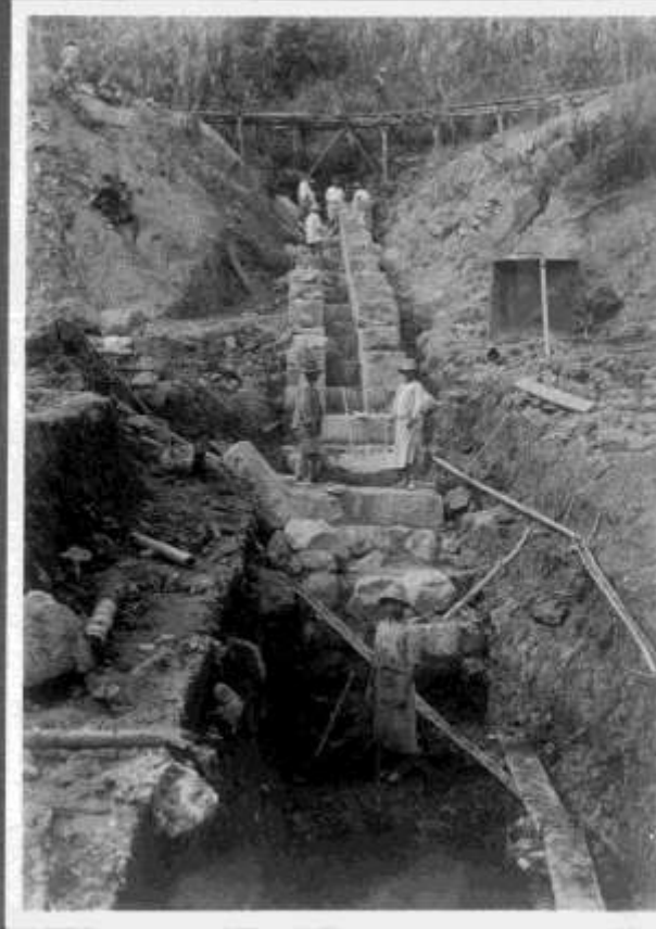
Obra # 145, Km 96+283, San Juan Sancti Spiritus P. C. E. C. M. C. A. 1954
