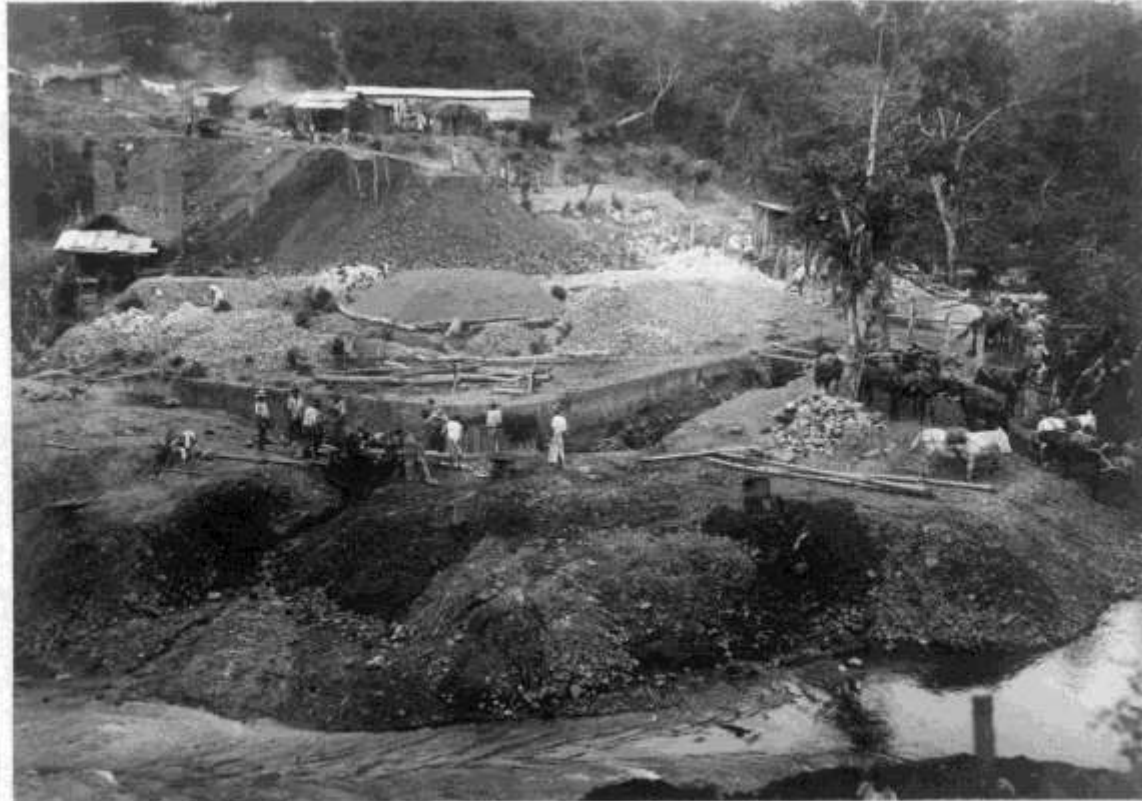
Obra #294, Km 106+012.50, Auskub für Brückenlage Seite Villala.
