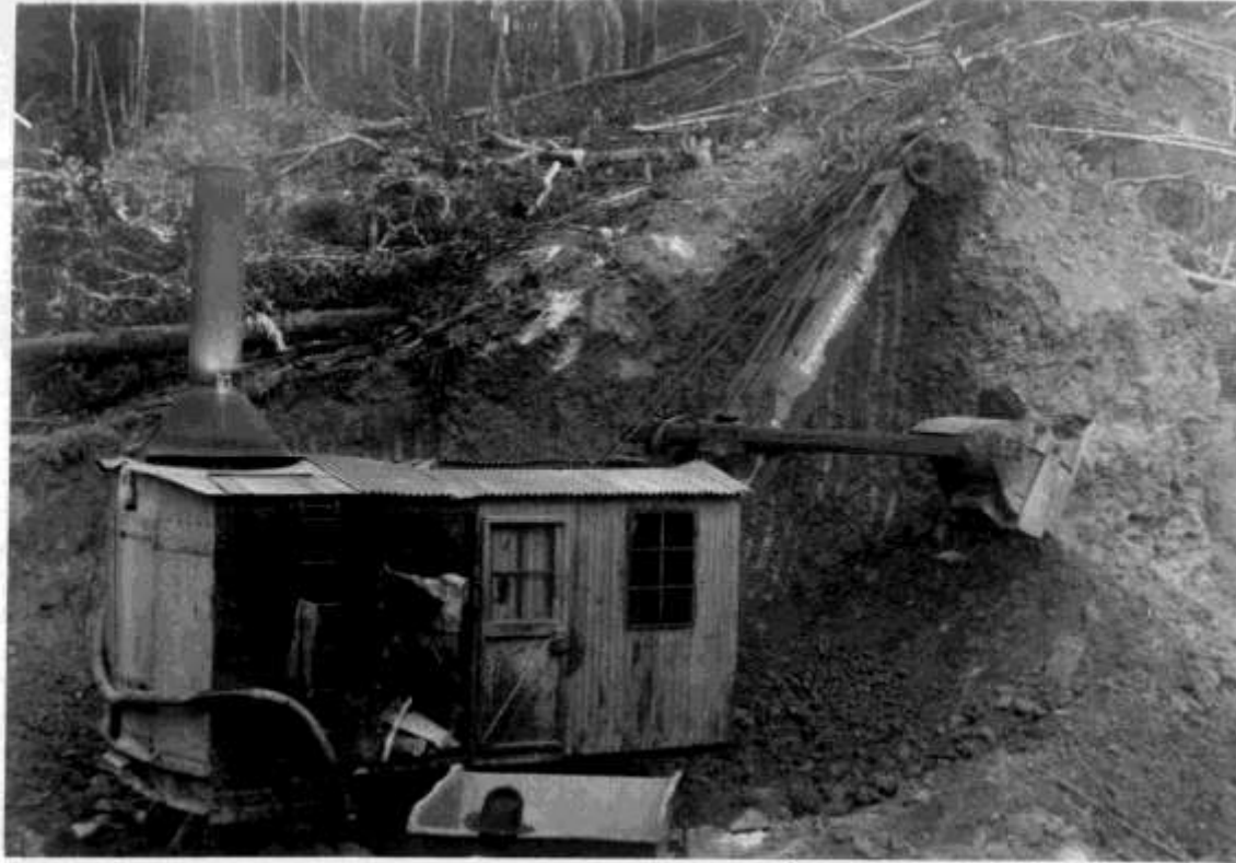
Puerto Llévano/Útica, Greifbagger beim Arbeiten
