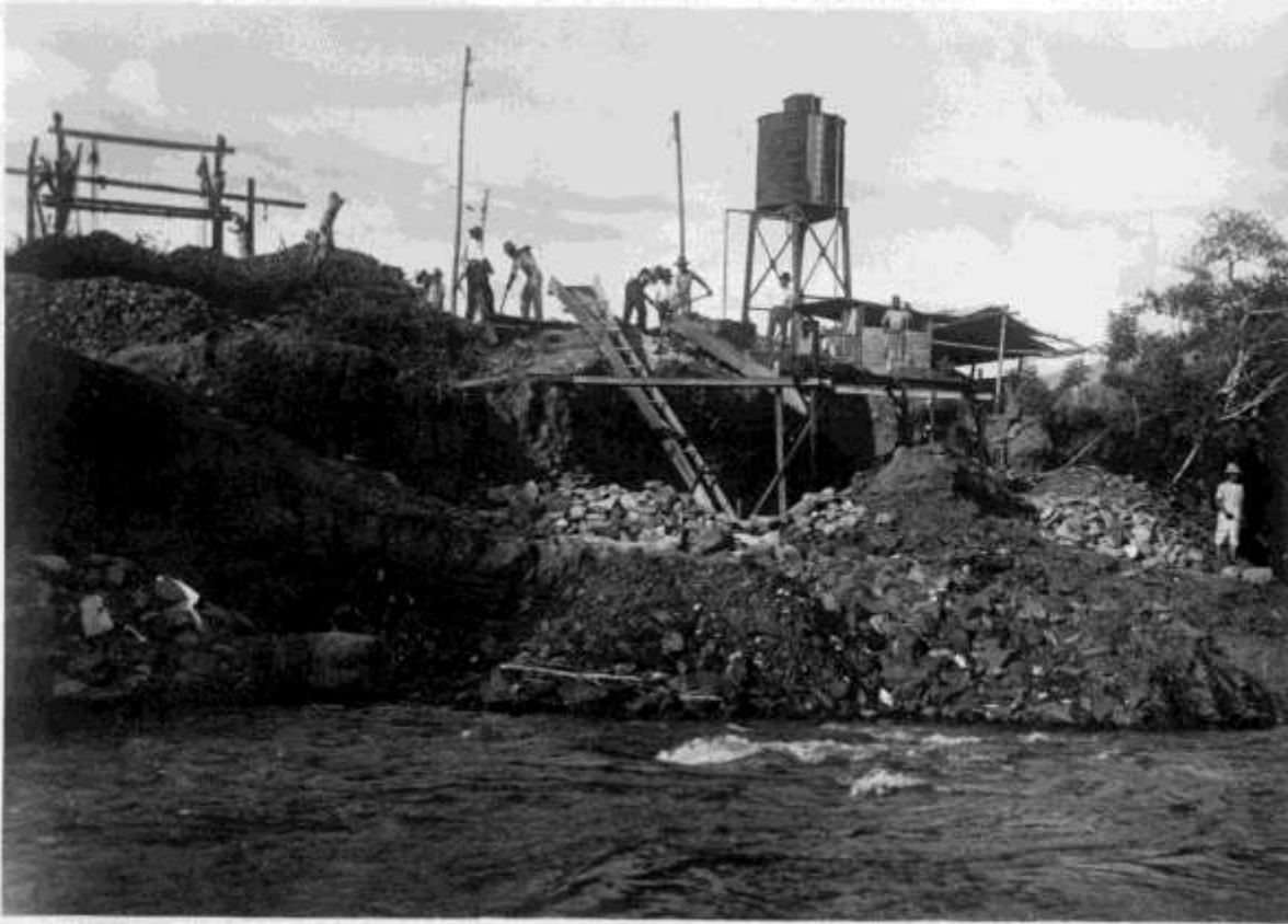
Bau der Brücke Rio Tilleta
