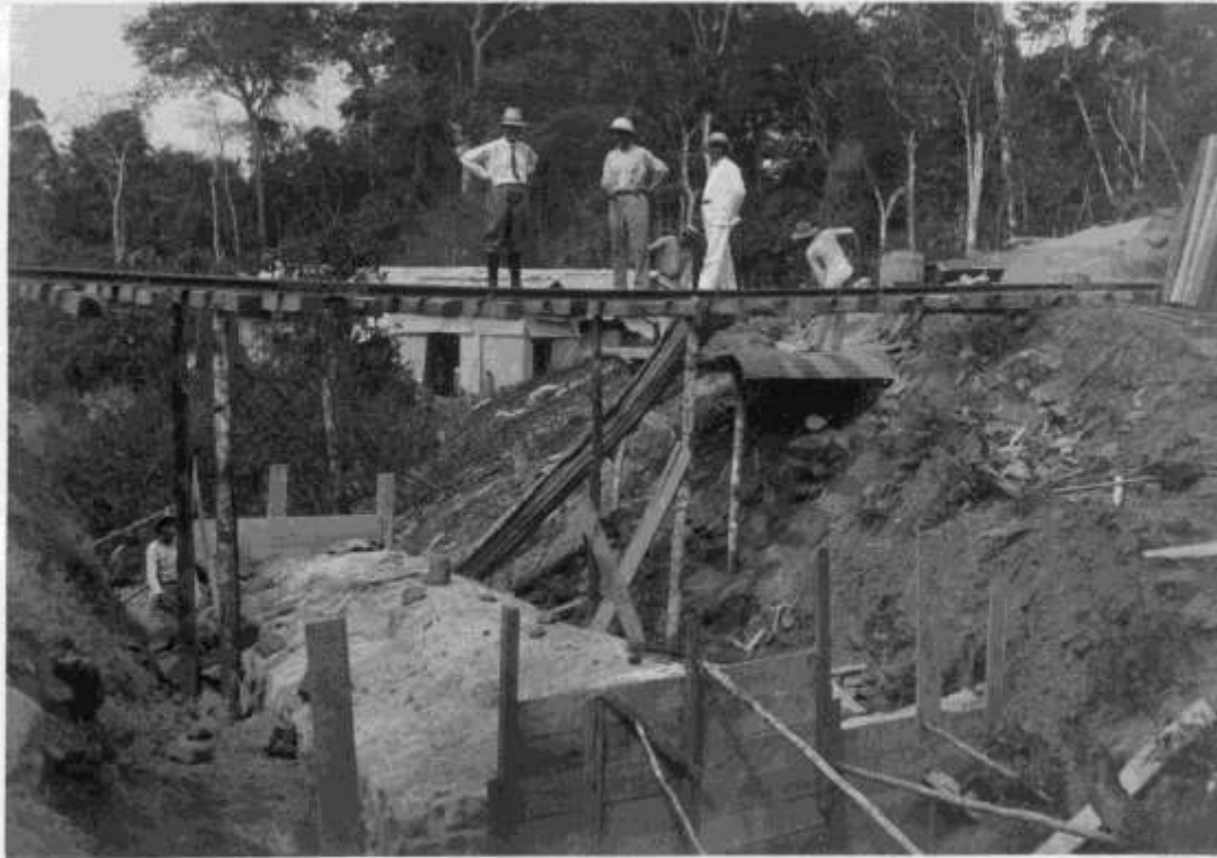
Puerto Piévanu/Útica Km 4,6, Gewölber Durchl.
