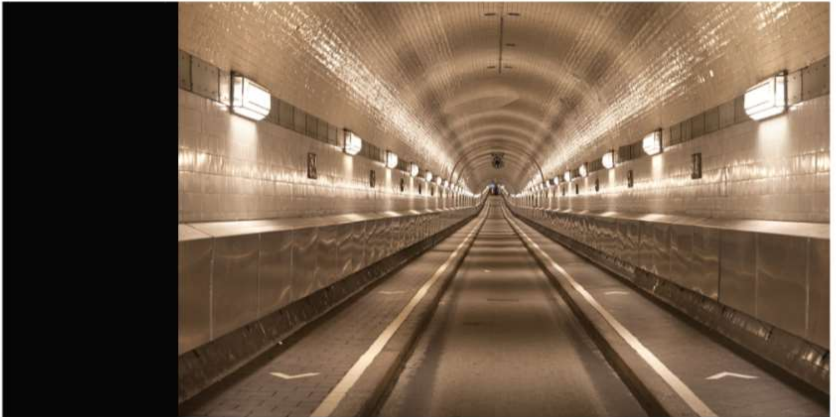
Antiguo túnel del Elba
