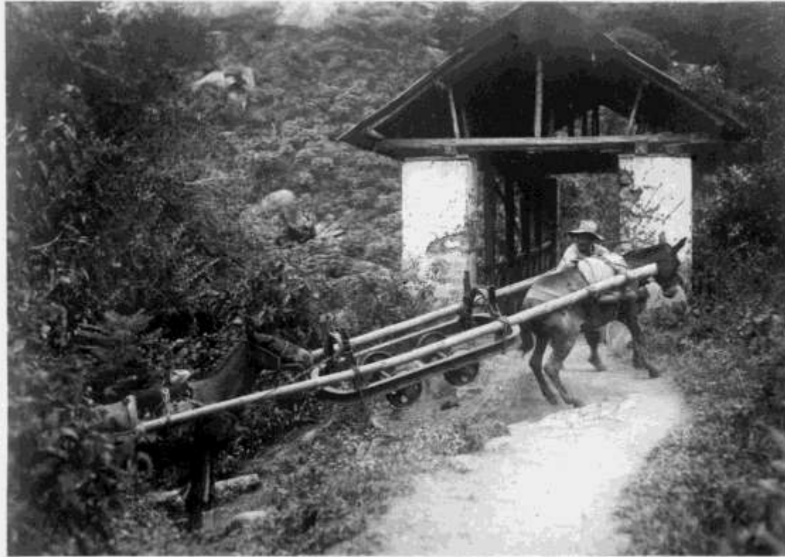
Brücke über Río Samay bei Santa Rosa (im 98+400)
