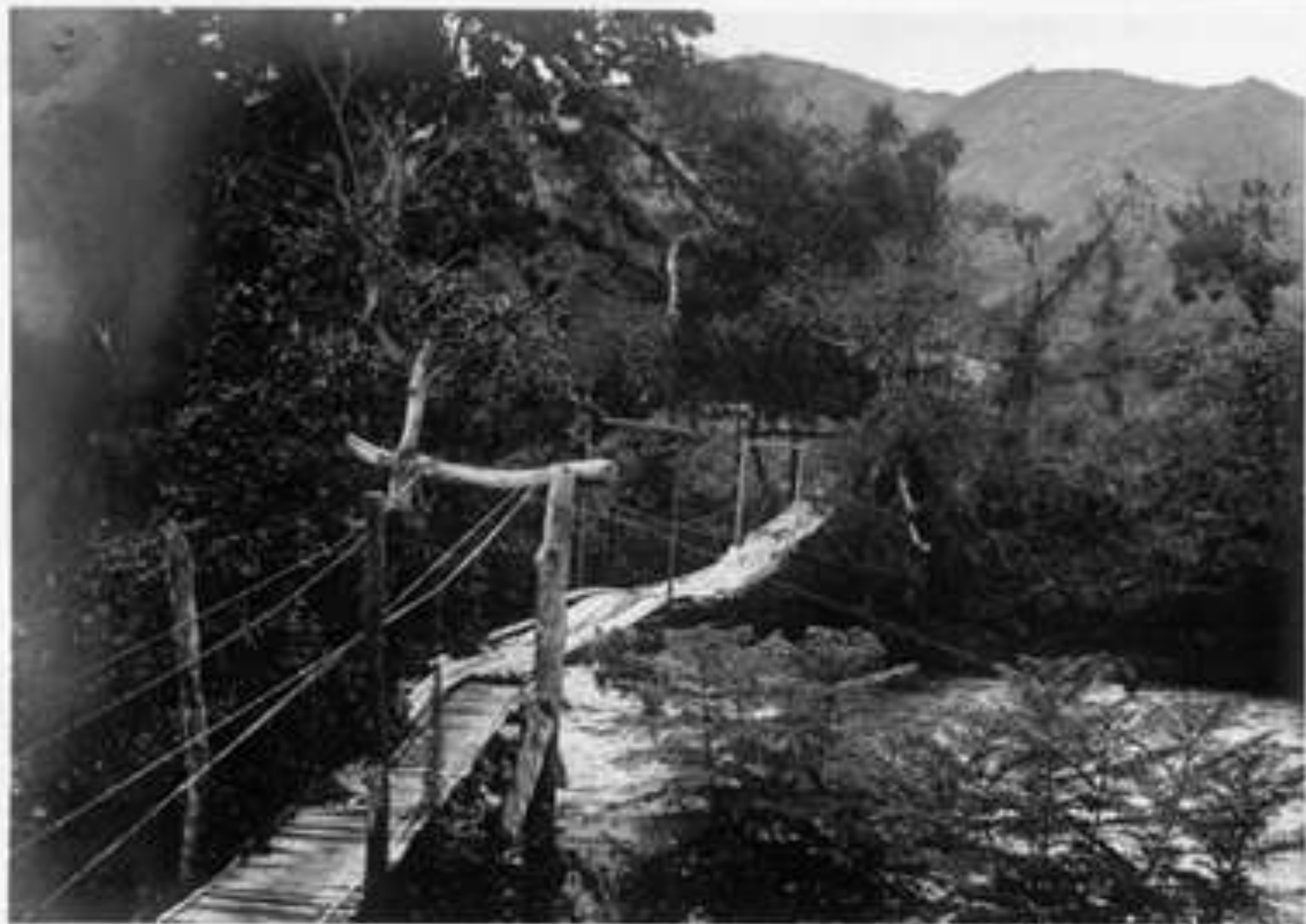
(Villeta - Albar) 4. Fußgängerbrücke aus Bambus über den Rio Villeta
